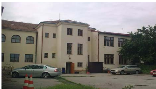
Dvorní fasáda stávajícího objektu
