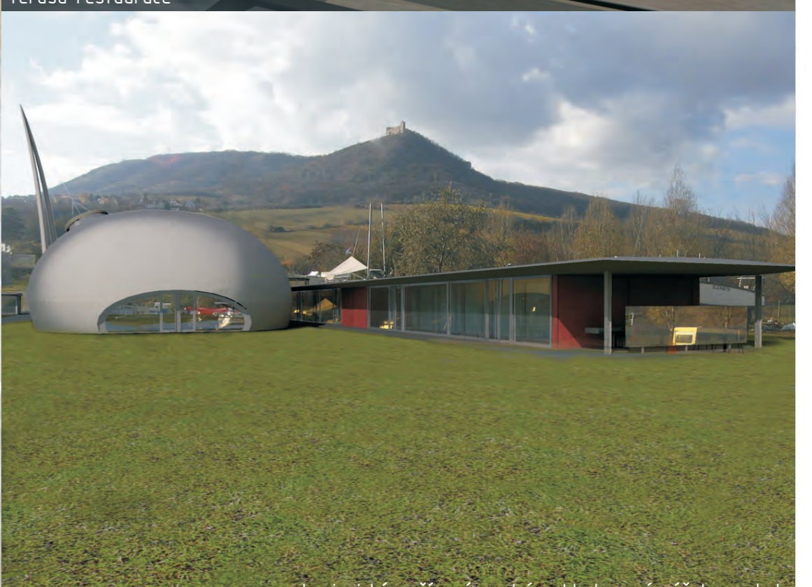
hygienické zařízení, zadní pohled na víceúčelovou halu
